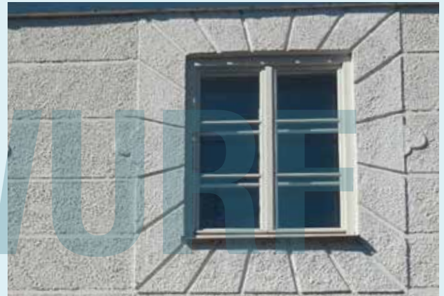
Fenster mit Einfassung im Bossenmauerwerk
