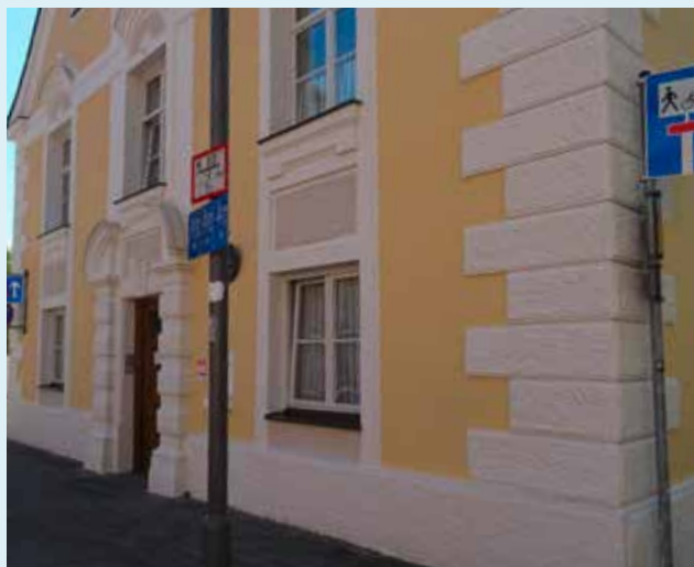
Beispiel für eine Fassade mit Bossenmauerwerk
