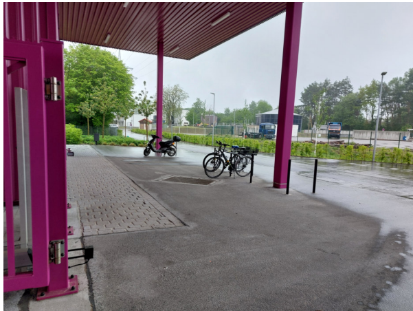
Abb.1: Einfahrt mit Überdachung
