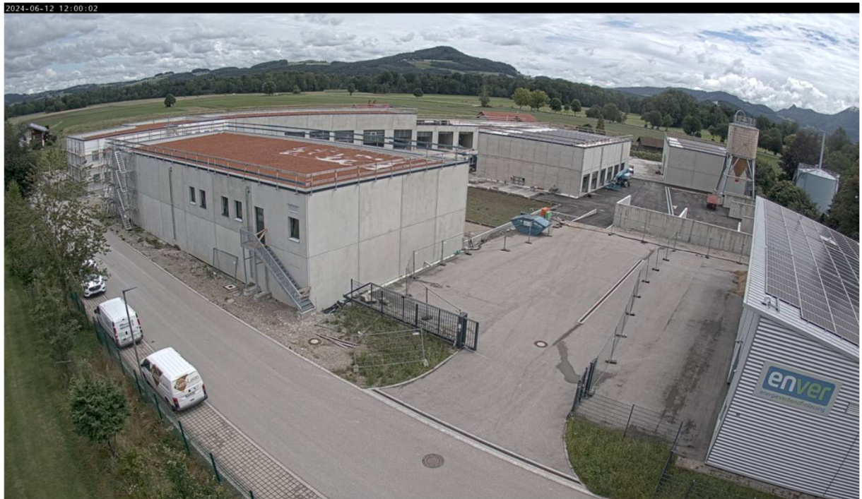
Baustellen Webcam Neubau Bauhof Freilassing ©Stadt Freilassing
