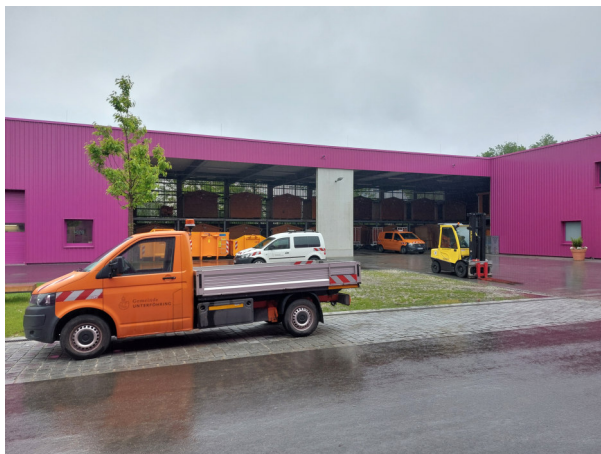
Abb.6: Offene Lagerhalle mit Markthütten
