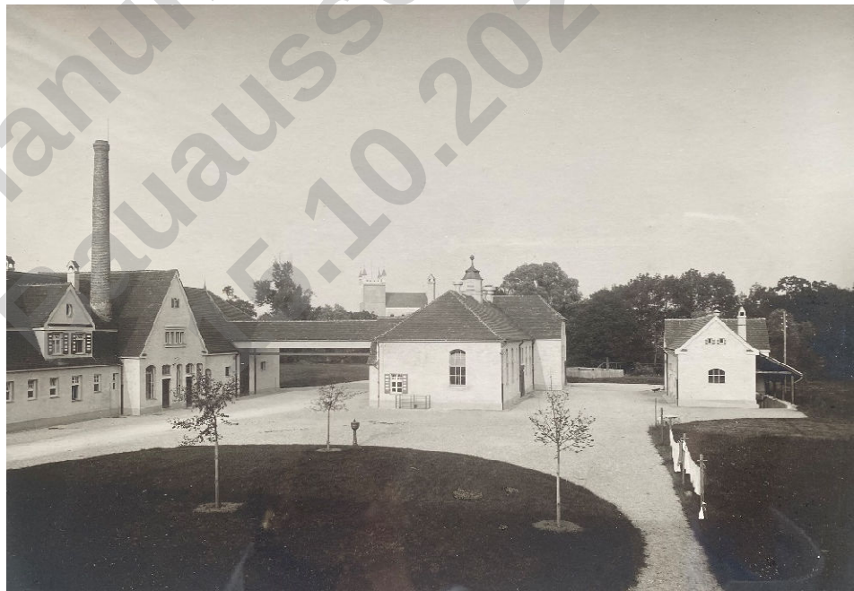
Bauzeitliches Foto des Kessel- und Kühlhauses (links), des Schlachthauses (Mitte) und der Pferdemezgerei (rechts)
