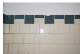
Wandfliesen Kühlhaus, Baderaum
